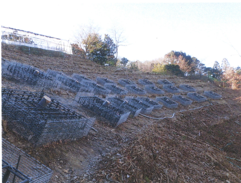
【独立受圧板の枠組状況例】
